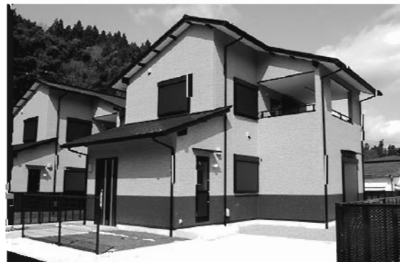
今年に整備された若者定住促進住宅
