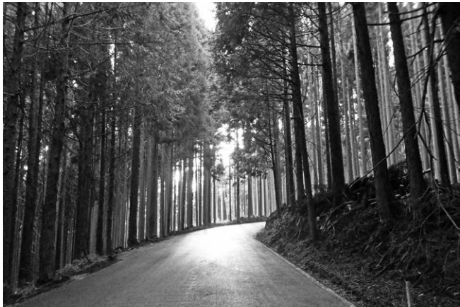
村道屏風線(長野)舗装修繕事業
