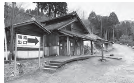
曾爾高原駐車場内のトイレ
