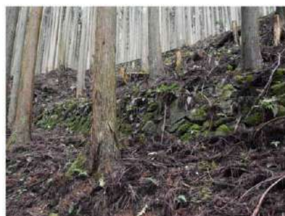
土留め石垣（山粕峠）
